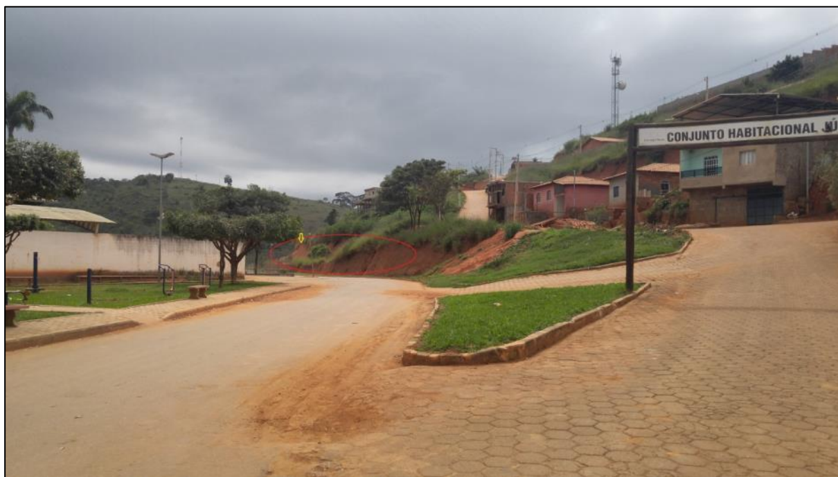
Figura 69 - Região onde ocorre escorregamento no município de Córrego Novo
