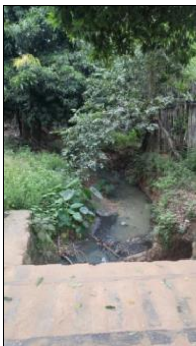
Figura 54 - Vista a montante da ponte 5
