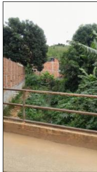
Figura 49 - Vista a jusante da ponte 2
