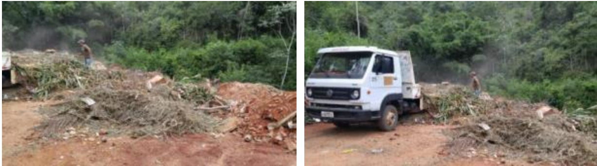
Figura 91 - Área de bota-fora para RCC e galhos
