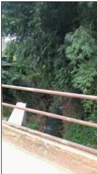
Figura 48 - Vista a montante da ponte 2
