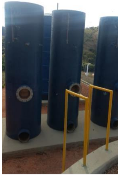
Figura 25 - Filtros recém-instalados na ETA
