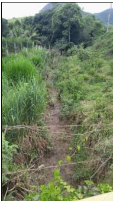
Figura 57 - Vista a montante da ponte 6
