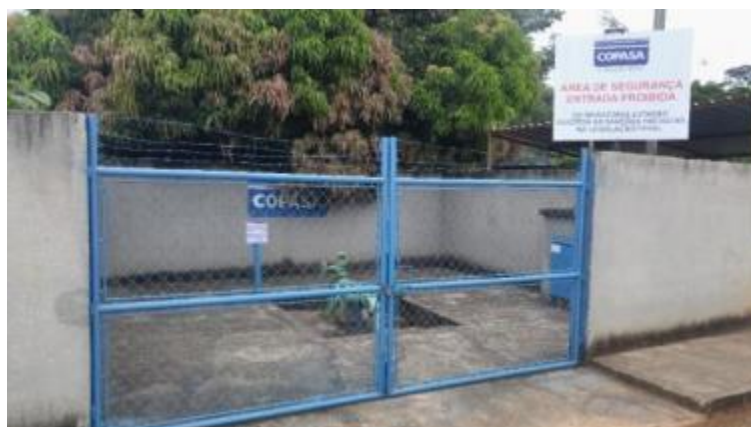
Figura 24 - Detalhes do poço C03
