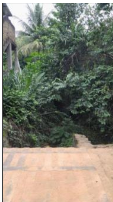
Figura 55 - Vista a jusante da ponte 5
