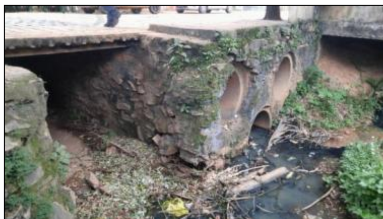
Figura 56 - Estrutura da ponte 5
