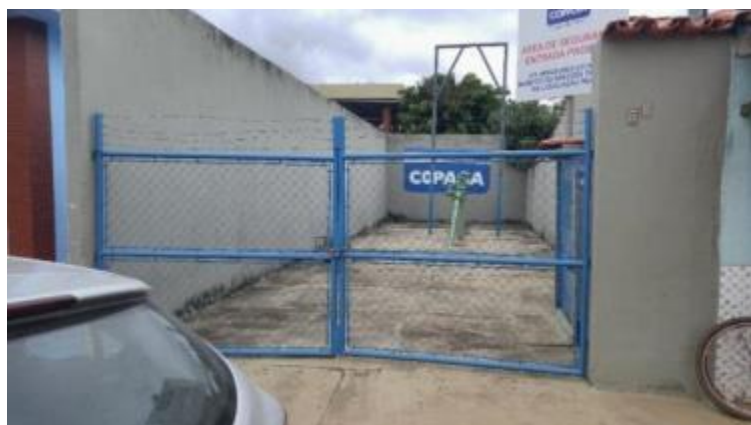
Figura 23 - Detalhes do poço C05
