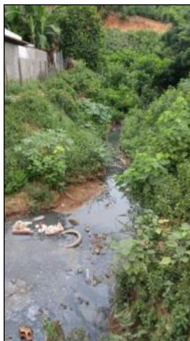
Figura 47 - Vista a jusante da ponte 1
