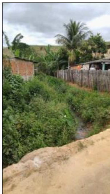
Figura 46 - Vista a montante da ponte 1
