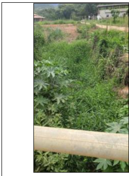
Figura 65 - Vista a montante da ponte 10
