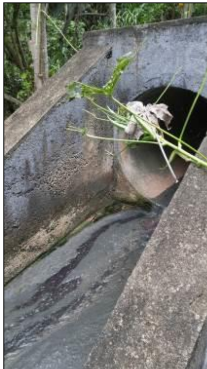
Figura 49 - Lançamento de águas pluviais 3 e de esgotos
