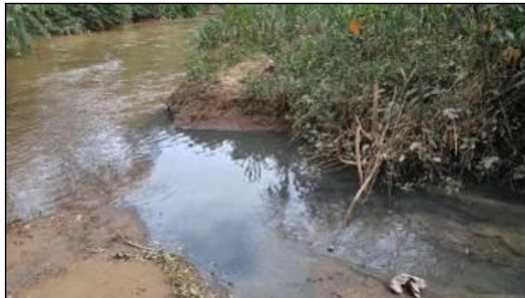
Figura 45 - Local de desaguamento do canal aberto no ribeirão Sacramento
