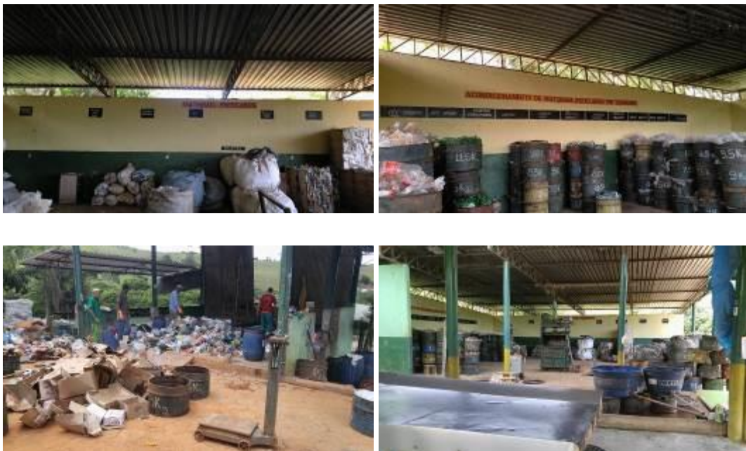
Figura 63 - Usina de Triagem e Compostagem de Resíduos Sólidos (UTC) de Pingo-d'Água
