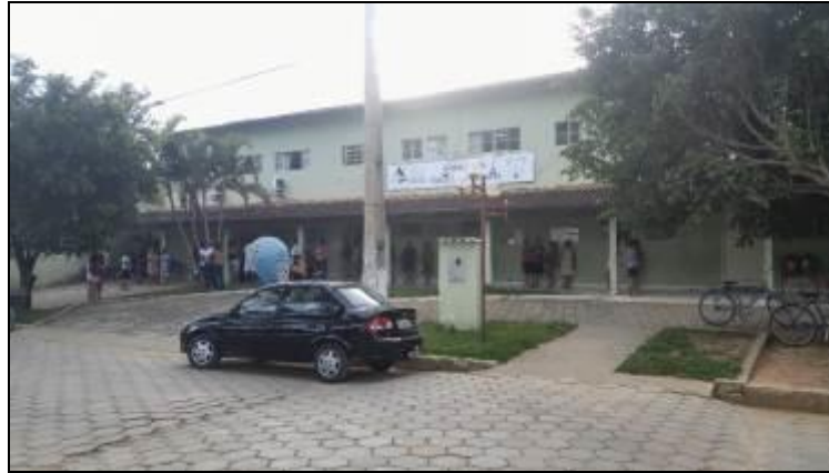
Figura 35 - Detalhe da pavimentação de bloquete sextavado
