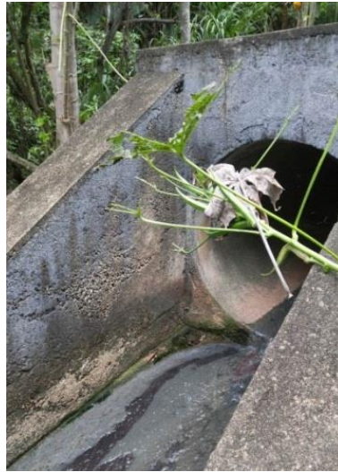
Figura 30 - Lançamento dos esgotos na galeria de águas pluviais
