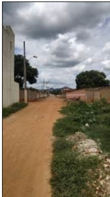
Figura 36 - Rua sem pavimentação
