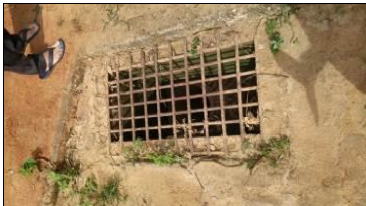
Figura 39 - Boca de lobo existente em Pingo-d'Água sem resíduos sólidos
