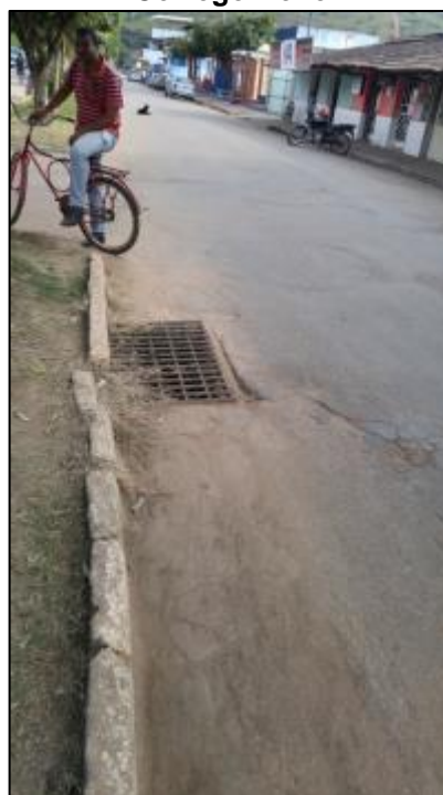
Figura 42 - Boca de lobo em situação recomendada por Tucci (1993) em Córrego Novo
