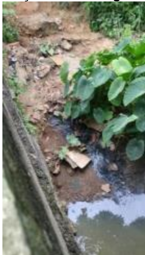
Figura 33 - Lançamento de esgotos no ponto 4
