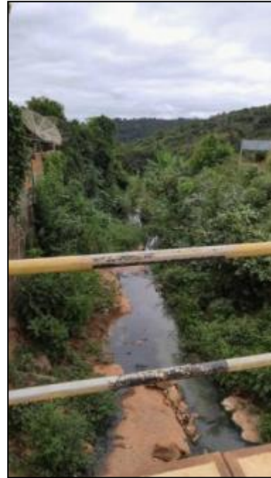
Figura 53 - Vista a jusante da ponte 4
