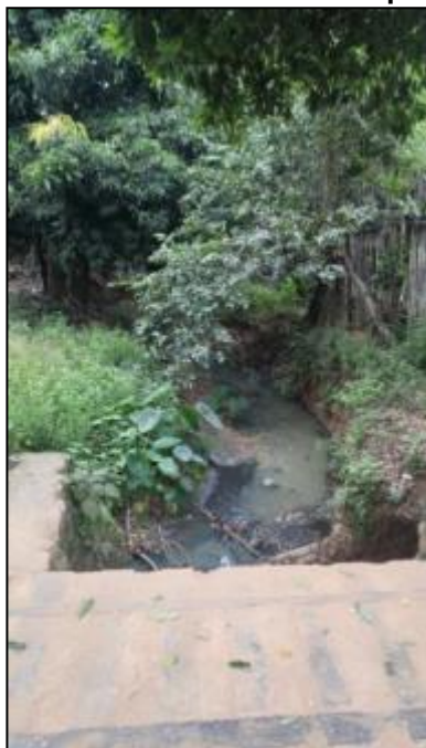
Figura 54 - Vista a montante da ponte 5
