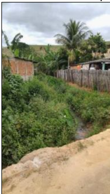
Figura 46 - Vista a montante da ponte 1
