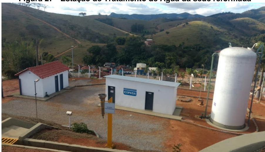
Figura 27 - Estação de Tratamento de Água da sede reformada
