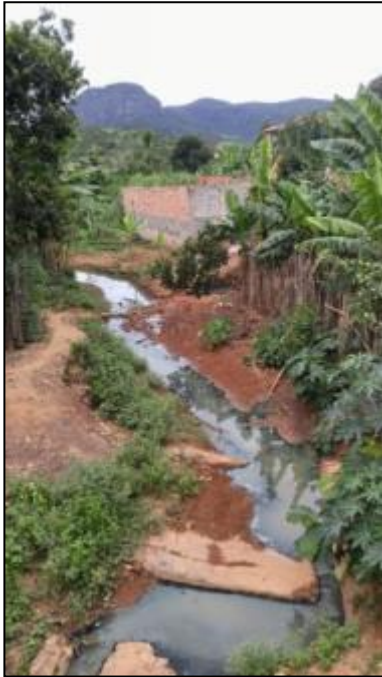
Figura 52 - Vista a montante da ponte 4
