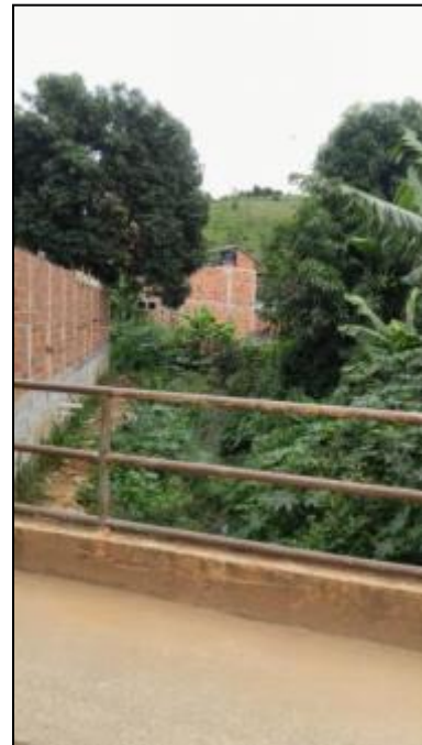
Figura 49 - Vista a jusante da ponte 2
