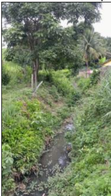
Figura 50 - Vista a montante da ponte 3
