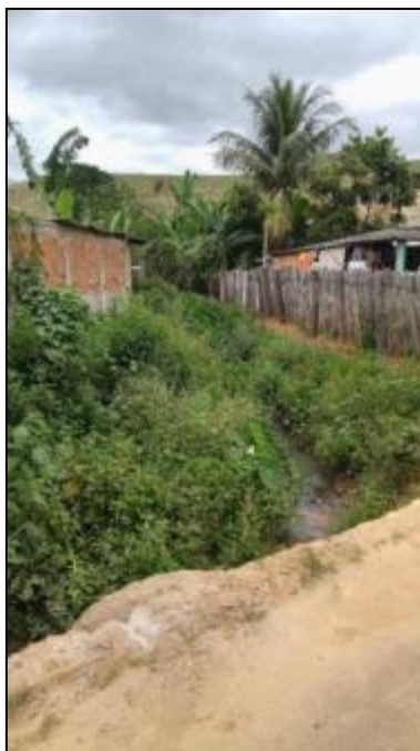
Figura 80 - Área de Preservação Permanente do curso d'água próximo à ponte 1 – Rua Francisco Caetano
