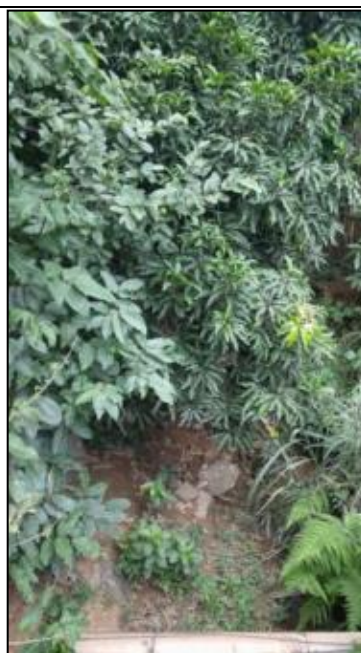
Figura 66 - Vista a jusante da ponte 10
