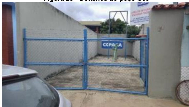
Figura 23 - Detalhes do poço C05
