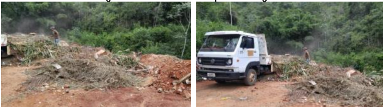
Figura 91 - Área de bota-fora para RCC e galhos
