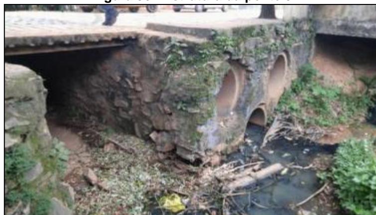
Figura 56 - Estrutura da ponte 5
