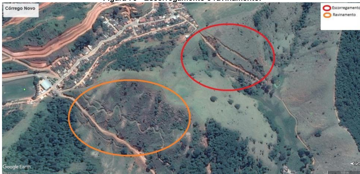
Figura 70 - Escorregamento e ravinamento.
