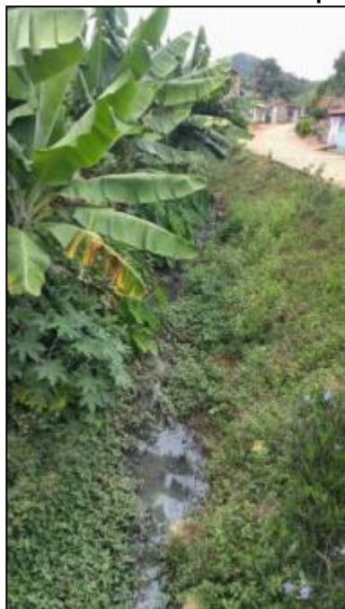
Figura 61 - Vista a montante da ponte 8
