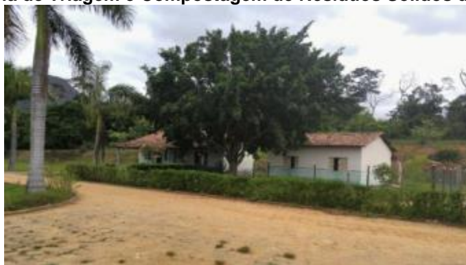
Figura 85 - Usina de Triagem e Compostagem de Resíduos Sólidos de Córrego Novo
