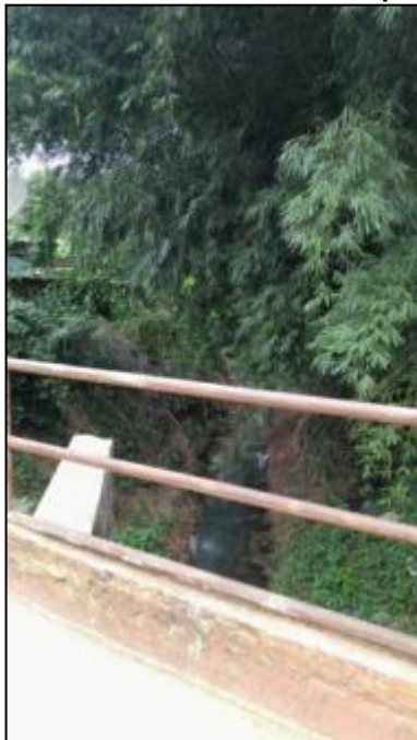
Figura 48 - Vista a montante da ponte 2
