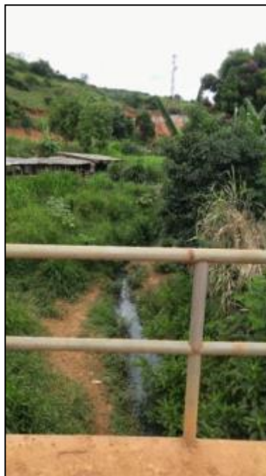
Figura 64 - Vista a jusante da ponte 9
