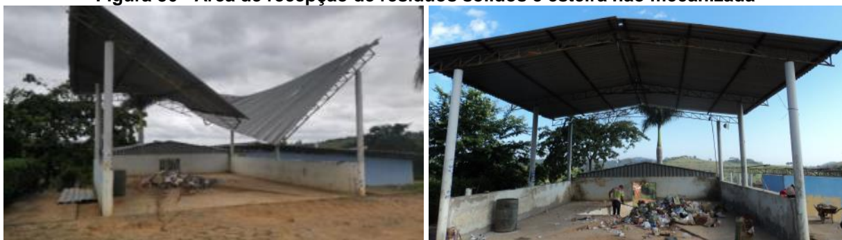
Figura 86 - Área de recepção de resíduos sólidos e esteira não mecanizada
