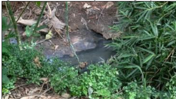
Figura 43 - Canal aberto do lançamento de águas pluviais 1
