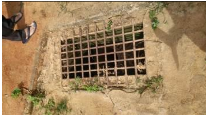
Figura 39 - Boca de lobo existente em Pingo D'Água sem resíduos sólidos
