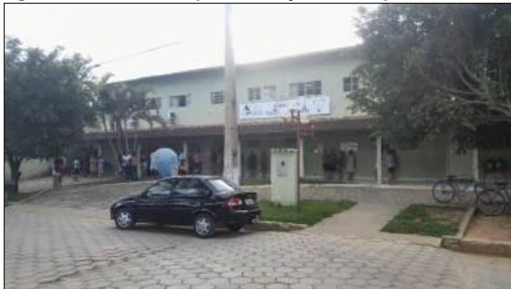
Figura 35 - Detalhe da pavimentação de bloquete sextavado
