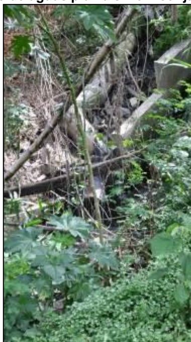
Figura 42 - Ponto de lançamento de águas pluviais 1 em conjunto com lançamento de esgotos
