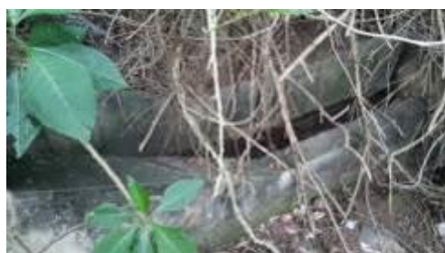
Figura 27 - Canal de concreto da drenagem que recebe os esgotos
