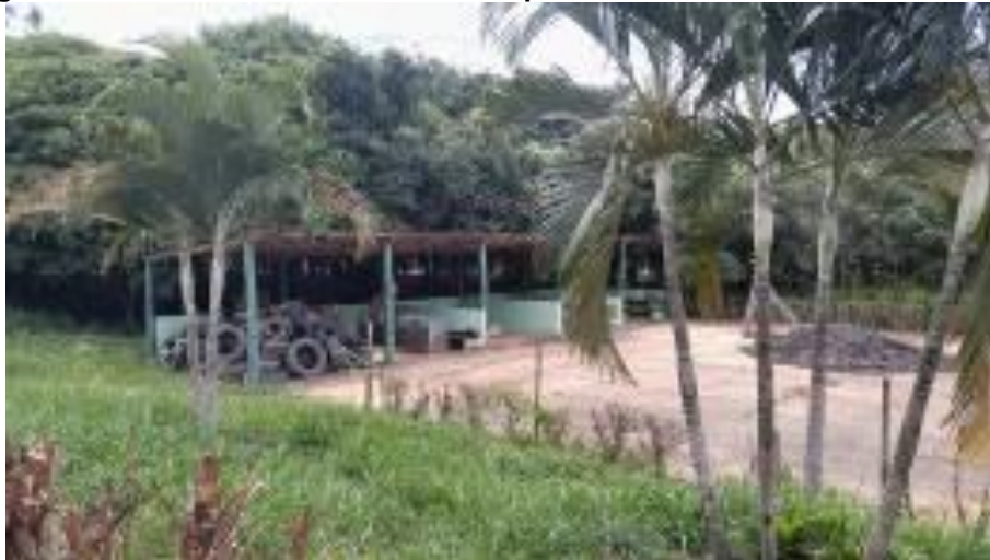
Figura 69 - Local de armazenamento de pneus e resíduos volumosos da UTC
