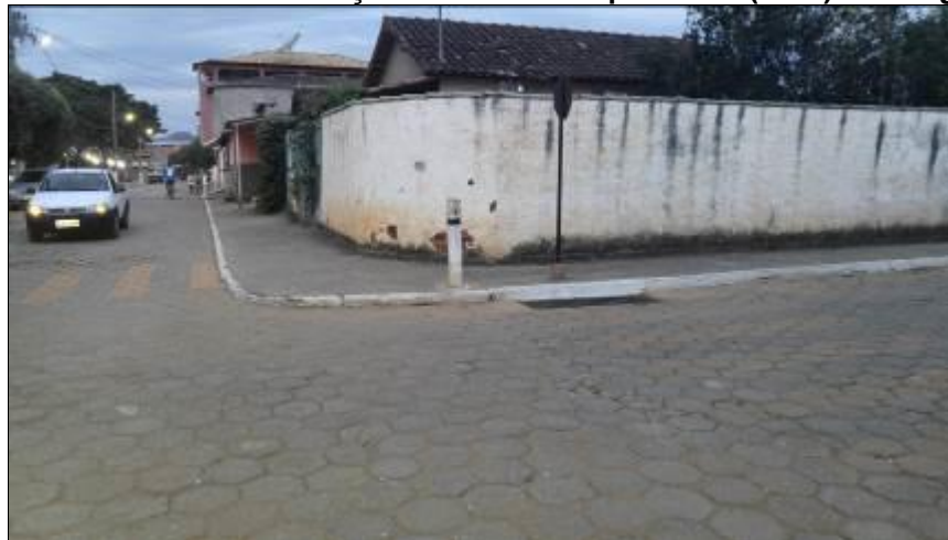
Figura 38 - Boca de lobo em situação recomendada por Tucci (1993) em Pingo D'Água
