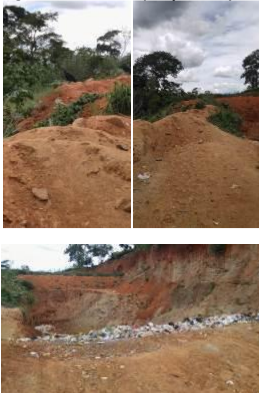
Figura 65 - Vala de disposição de rejeitos
