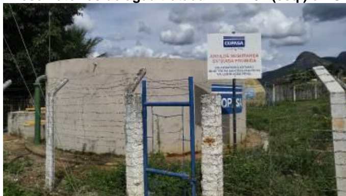
Figura 23 - Reservatórios de água tratada RAP-R01 (esq.) e RSA-R02 (dir.)
