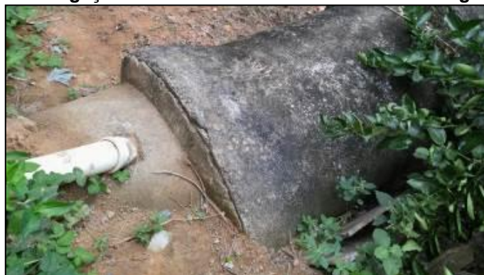
Figura 48 - Interligação da rede coletora à rede coletora de águas pluviais
