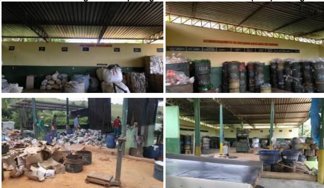
Figura 63 - Usina de Triagem e Compostagem de Resíduos Sólidos (UTC) de Pingo D'Água
