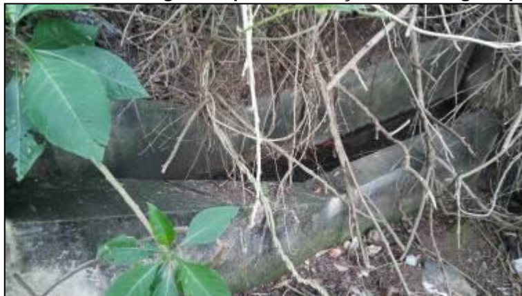
Figura 46 - Rede de drenagem no ponto de lançamento de águas pluviais 2
