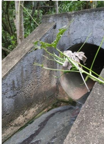
Figura 30 - Lançamento dos esgotos na galeria de águas pluviais
