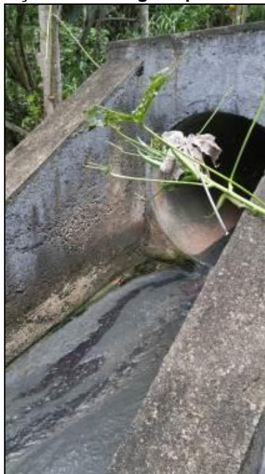
Figura 49 - Lançamento de águas pluviais 3 e de esgotos
