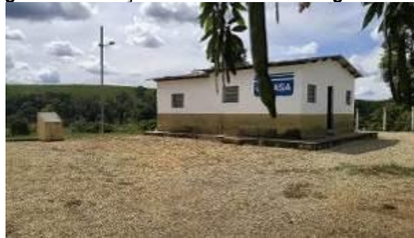
Figura 22 - Estação de Tratamento de Água da sede
