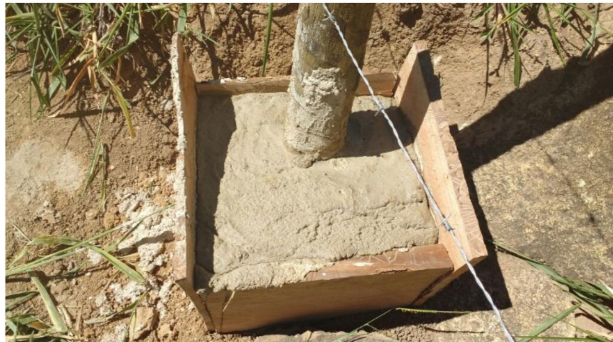
Fixação de mourão de cerca sobre terreno rochoso
