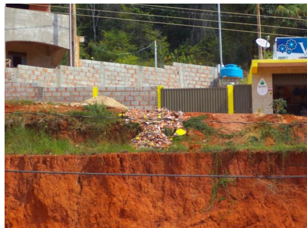
FIGURA 8 - RCC DEPOSITADO EM TERRO VAZIO 2 (FONTE: ACERVO DO AUTOR, 2014)
